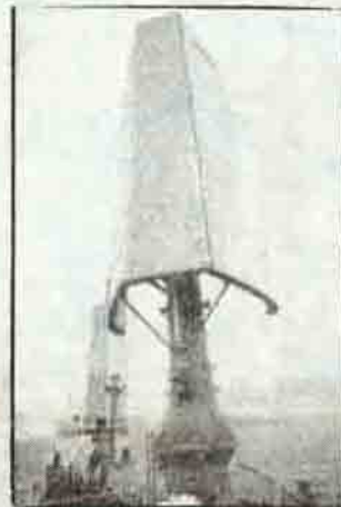
Shin-Aitoku Maru'nun bilgisayar, yaklaşık 35 millik bir rüzgarda geminin dizel motorla- rını kapatarak yelkenlerini açıyor ve gemi 12 deniz mili hızla yolunu sürdürüyor.
